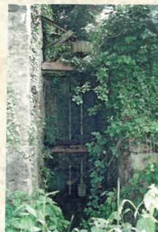
**Roue à Turbine au moulin du Grand Beuray Base de la chute d'eau axe de la turbine disposé à l'horizontal en 2000**
