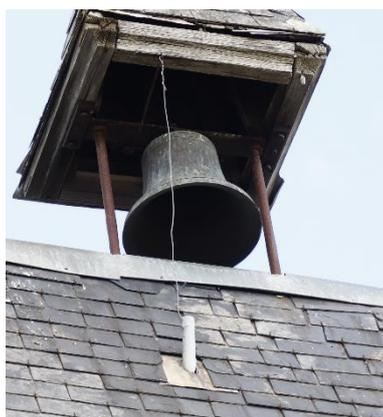
Dans le bas-côté sud à gauche de la porte, les poids du système horloger sont toujours présents. Au niveau du clocheton en observant bien, on distingue ; un câble fixé à une tringle qui peut actionner le marteau situé coté est de la cloche.
