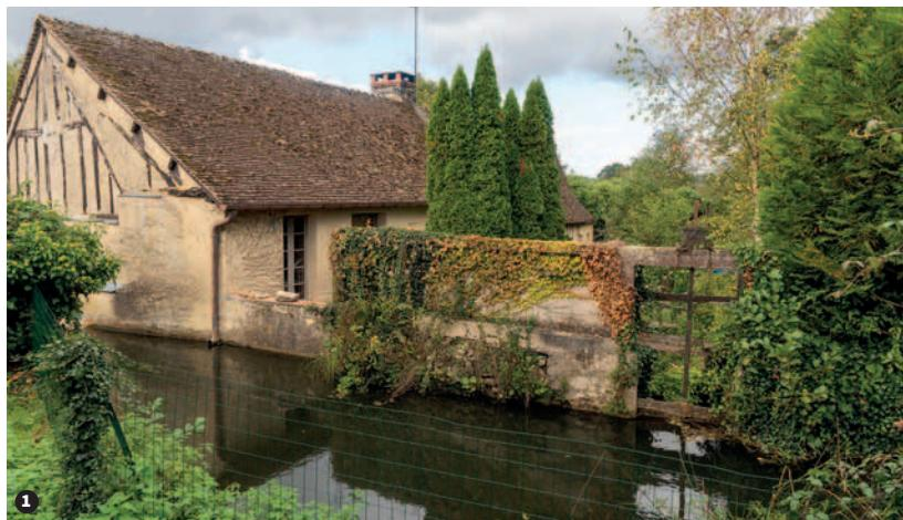
Moulin de Cherruau : ❶ Le bief, la vanne de décharge et le bâtiment sur lequel s'appuyaient les roues. ❷ Le mécanisme. ❸ La chute d'eau qui alimentait la roue en pignon. ❹ La charpente d'assemblage de la grange.
